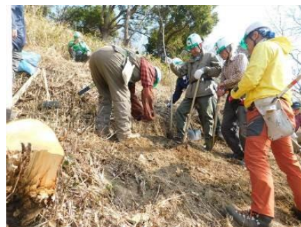
下穴掘り作業
