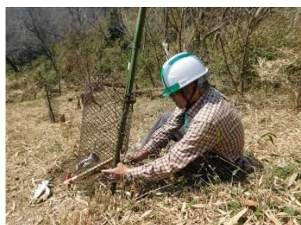
ウッドガードの取り付け
