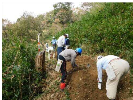
作業道の整備作業
