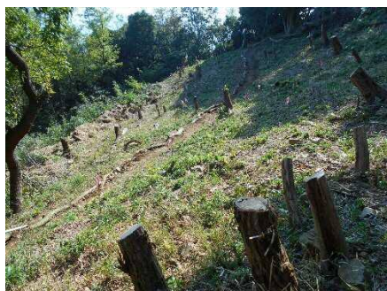
完成した中央作業道です
