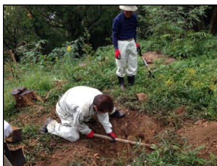
看板移設作業
