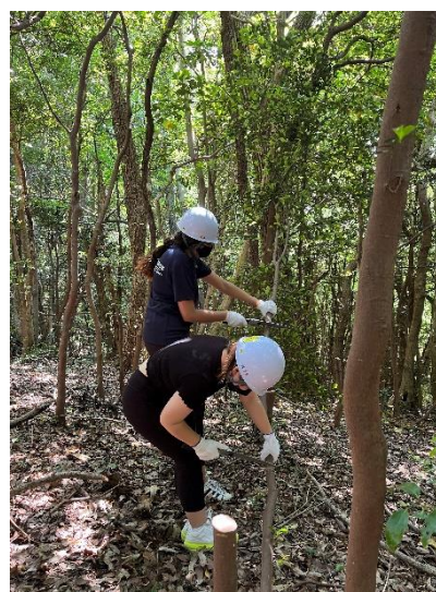
伐採木の処理
