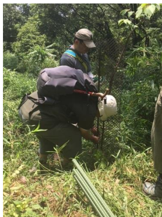
ウッドガードの取付け
