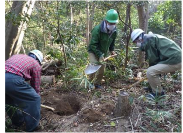
モニュメント設置用の穴掘り
