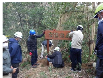
埋め込み作業
