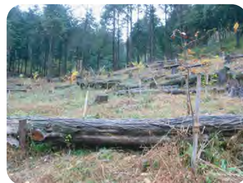
○整備状況の一部です。 ヒノキを伐採して苗木の植栽 をしています。
