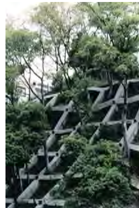
樹木を残した法枠工
