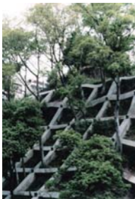
地中に鉄筋やアンカーを入れて崩壊を防ぎます 表土や植生を残すことができる鉄筋挿入工
