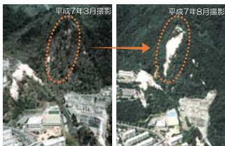
地震後の降雨により発生した鶴甲団地上流の新たな山腹崩壊
