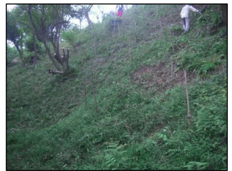
すっきりした斜面
