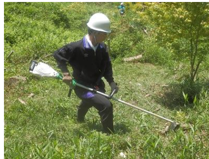
刈払機での作業
