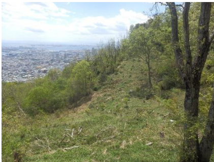
きれいになった作業後の谷筋
