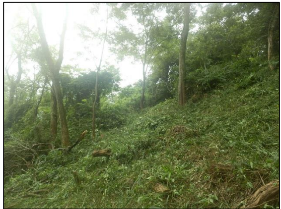
作業後 すっきりしました
