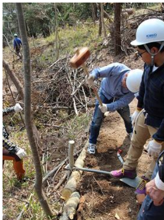
作業道の杭打ちはしんどいぞ
