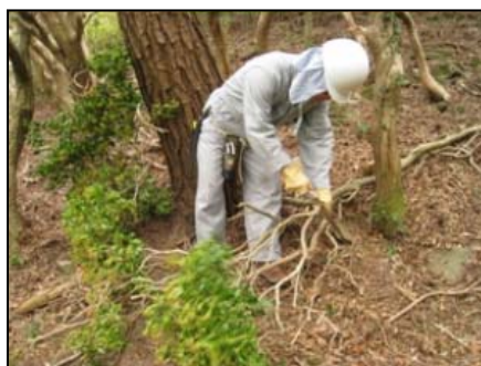
安全に配慮しつつ斜面で作業
