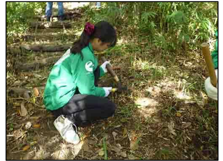
階段用の杭づくり
