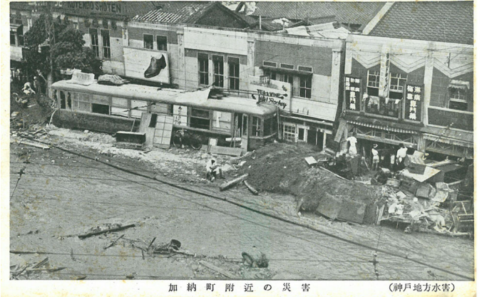
加納町附近の災害 (神戸地方水害)
