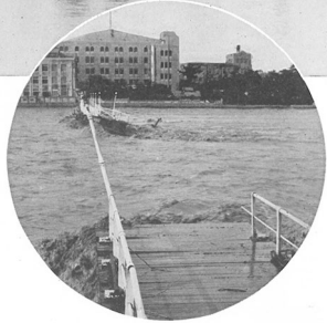
(害水方地神阪) 水濁るす蓋汎に上路線近附口東宮西(上) 失流の橋寶迎塚寶(下)
