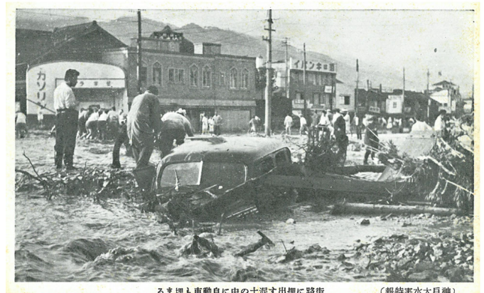
るま埋も車動自に中の土泥す出押に路街 (報特害水大戸神)
