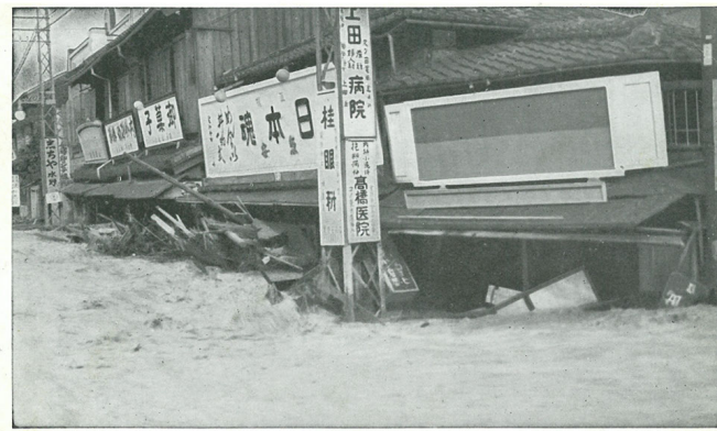
加納町附近の浸水状況 (神戸地方水害)
