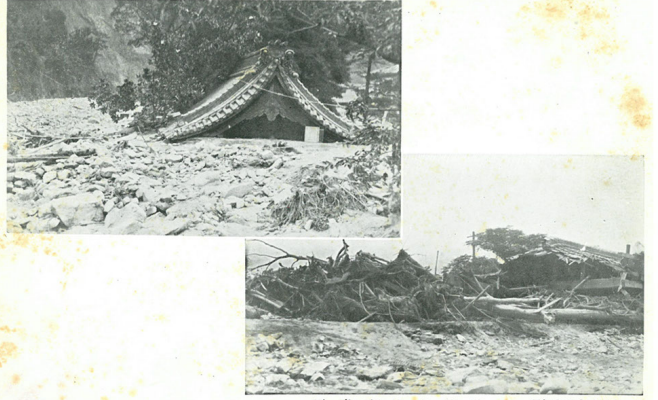
倒壊家屋の状況 (神戸地方水害)
