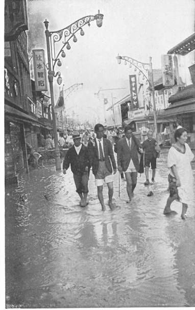
元町通りの浸水 (神戸地方水害)
