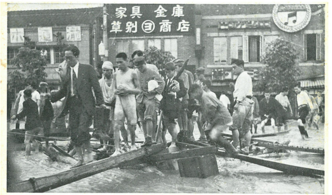
橋太丸の渡を流激し溢氾水濁に路街道瀧 (報特害水大戸神)
