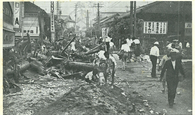
加納町附近の復舊作業 (神戸地方水害)
