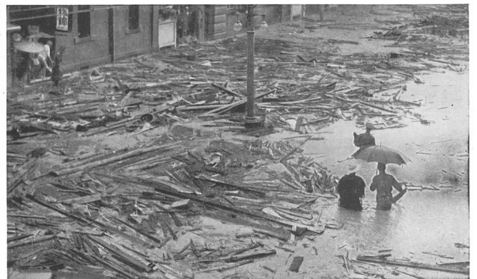
榮町通りに押寄せた流木 (神戸地方水害)
