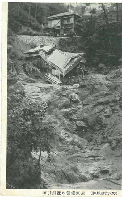
布引附近の倒壊家屋 (神戸地方水害)
