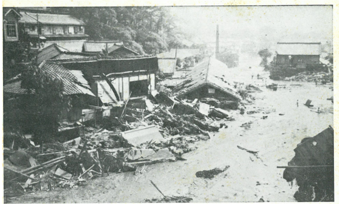
状態るす没埋に砂土も屋家も路街も川てし瀧沓川谷青 (報特害水大戸神)
