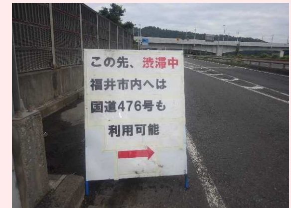
国道8号河原高架橋
