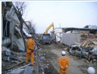
ダンプトラックによる搬出
