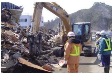
ガレキの撤去作業
