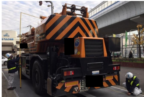
計測状況 (国道43号 兵庫県西宮市)
