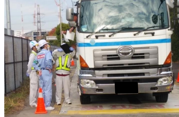
運転手説明・確認状況 (国道1号 大阪府枚方市)
