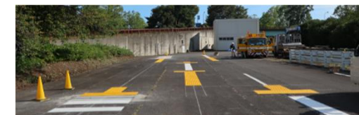
予備実験(踏切手前部)の誘導表示等の敷設状況
