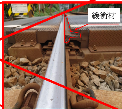
写真 2-1-33 緩衝材の設置事例
