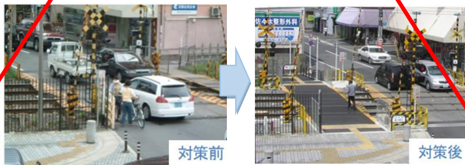
写真 2-1-26 踏切拡幅（歩道新設）の例
