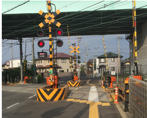
写真 2-1-30 踏切内において視覚障害者の進行方向を案内している事例
