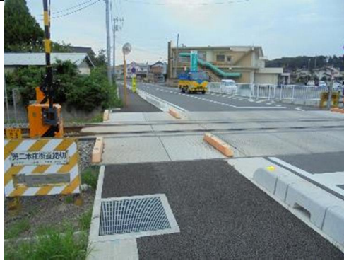
写真 2-1-27 縁石等により分離している例
