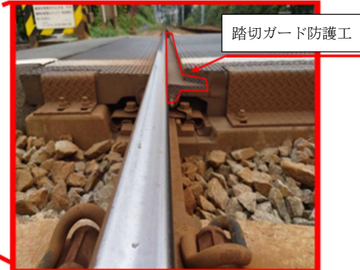
写真 2-7-● 踏切ガード防護工の設置事例
