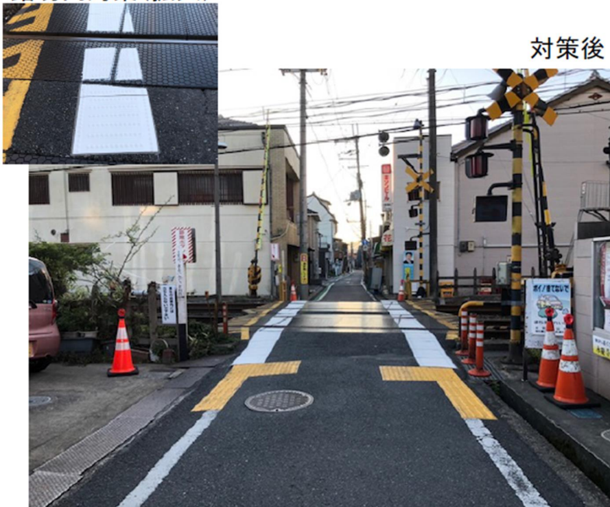
写真 2-7-● 踏切道手前部及び踏切道内に視覚障害者誘導用ブロック等を設置した事例
