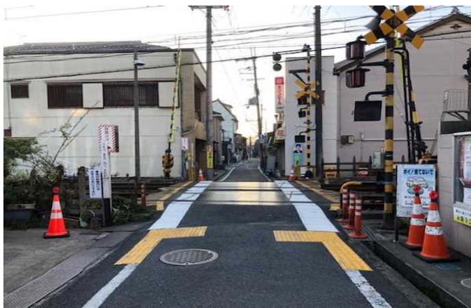
視覚障害者誘導用ブロックを 設置している事例 (奈良県大和郡山市)
