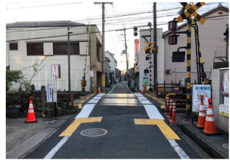
奈良県大和郡山市の事例 (歩車分離されていない道路での誘導用ブロック等の設置事例)
