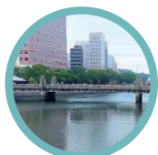
広島市 京橋 1927年架設 橋齢96年
