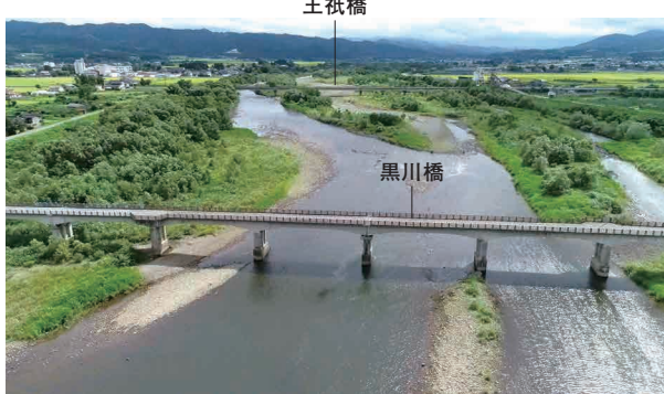
手前が撤去する黒川橋、奥が迂回路の王祇橋。約400m離れた距離にある
