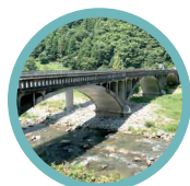
鳥取県 若桜橋 1934年架設 橋齢89年
