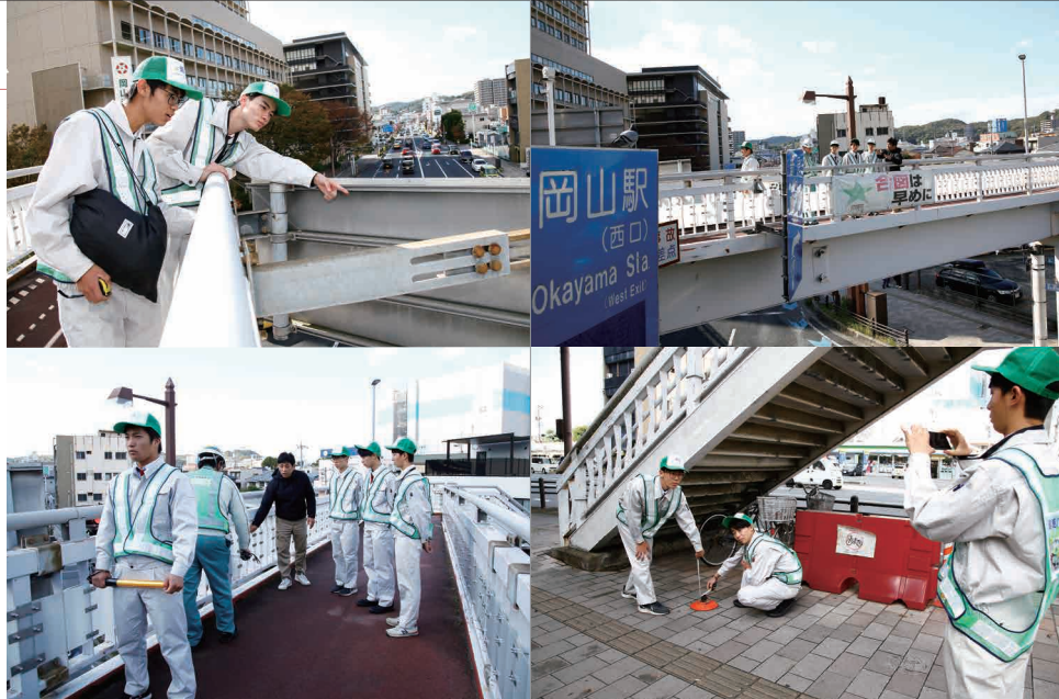
岡山市内の国道180号清心町交差点に架かる歩道橋や歩道を点検する生徒たち。
