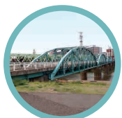
福島県 松齢橋 1925年架設 橋齢98年
