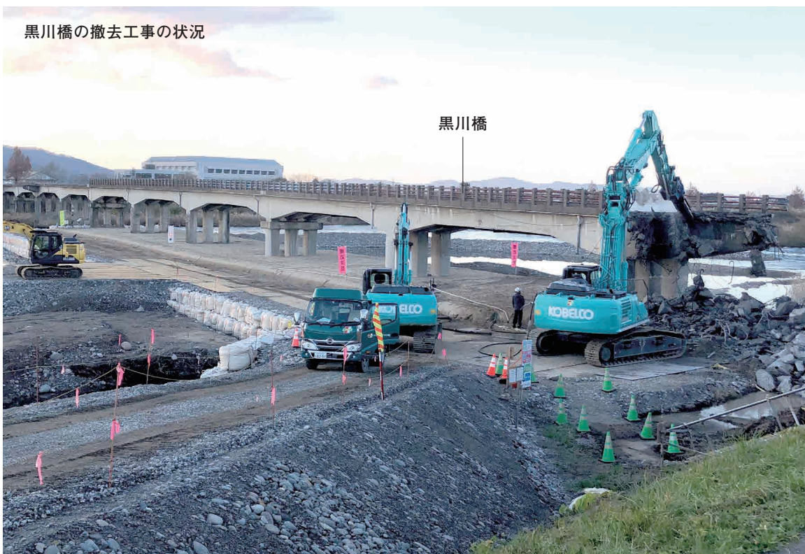
令和5年10月より黒川橋の撤去工事がはじまった。
