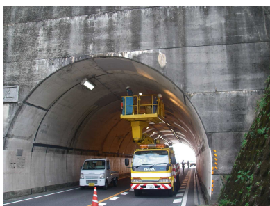
トンネル施設点検状況
