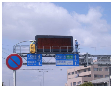
道路情報板の点検
