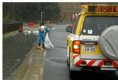
道路巡回（落下物の処理）
