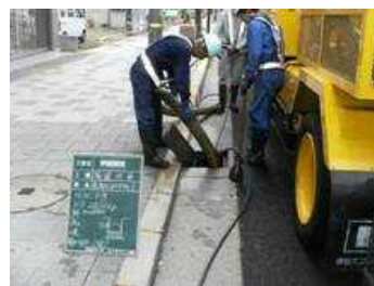
排水構造物清掃
