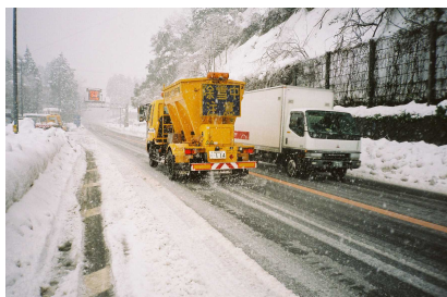
凍結防止材の散布作業
