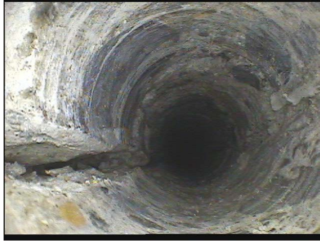
図一解 10.3.3 小径コア（φ25mm）とファイバースコープを用いてひび割れ深さを調査した事例
