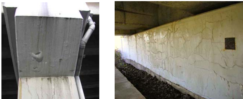
図一解 5.6.1 表面保護工法（遮水系）の再劣化事例
