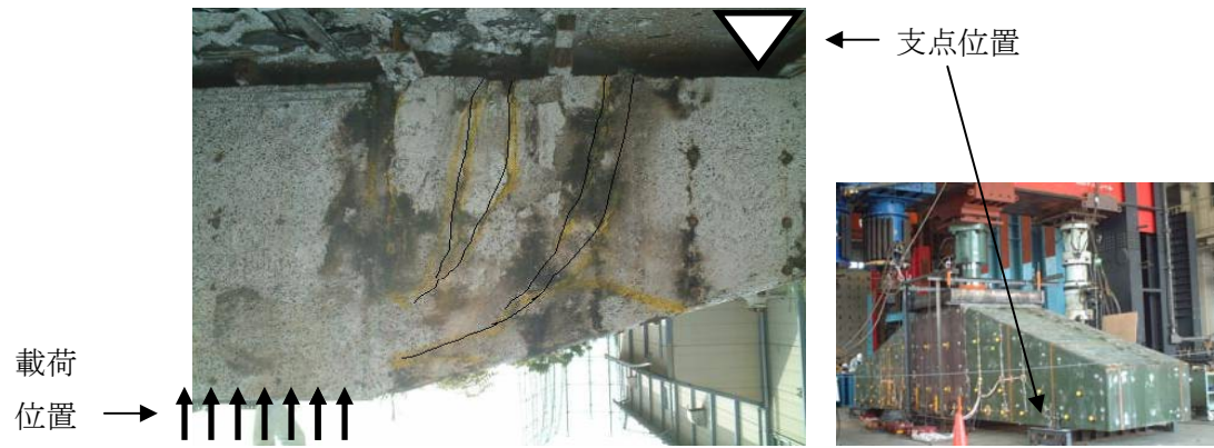
図一解 4.2.4 曲げひび割れの例 (T型梁供試体の荷重実験, 天地を逆に示す)
