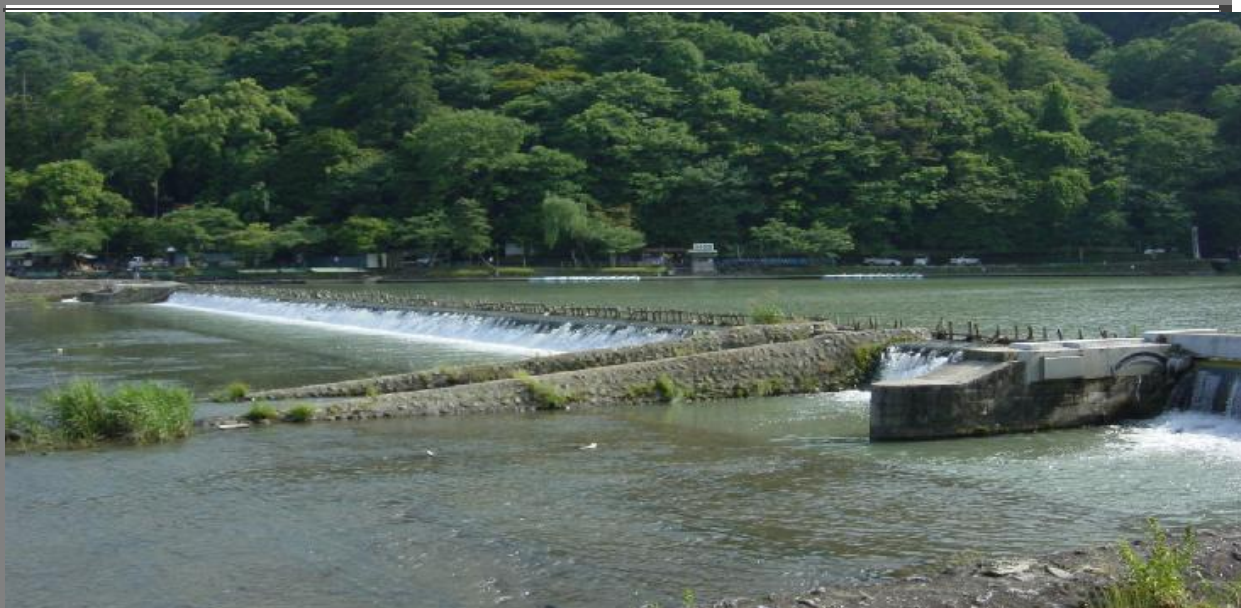
桂川左岸から見た葛野大堰
