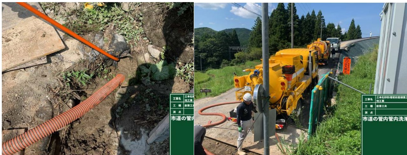
写真7. 水路の清掃状況
