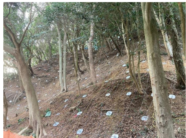
写真-2 東側斜面：斜面西側より撮影
