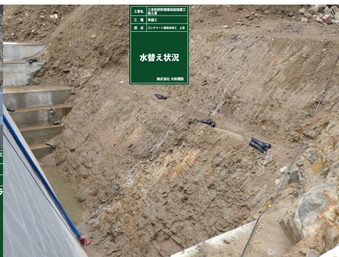
写真 6.工事用ポンプ
