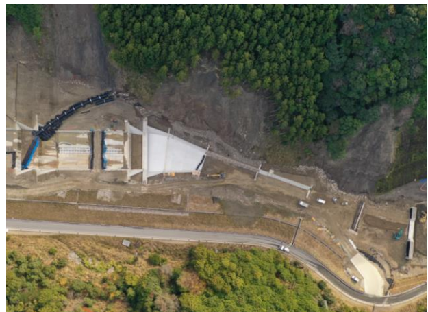
施工状況 空撮【流路】
