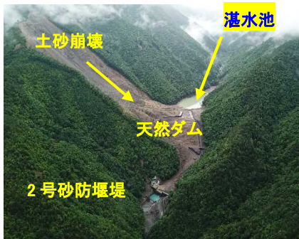
写真1. 河道閉塞 (下流より)
