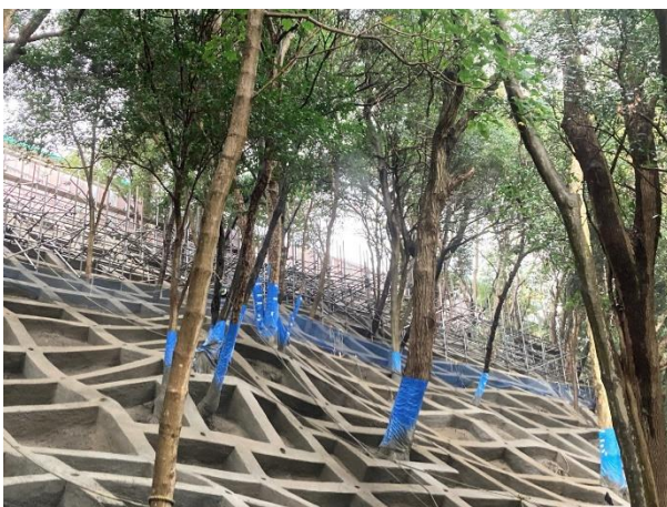
写真-1 西側斜面：斜面南側より撮影
