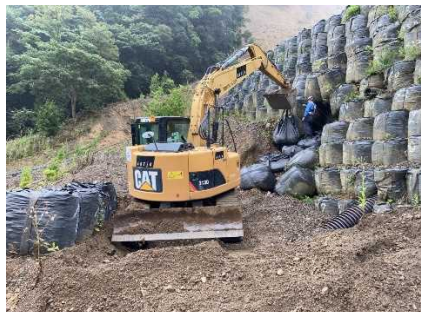
写真8. 周辺設備補修
