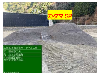
写真10. 鉄鋼スラグ補修材
