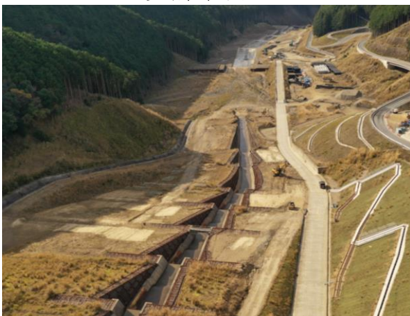
施工状況 空撮【落差工】
