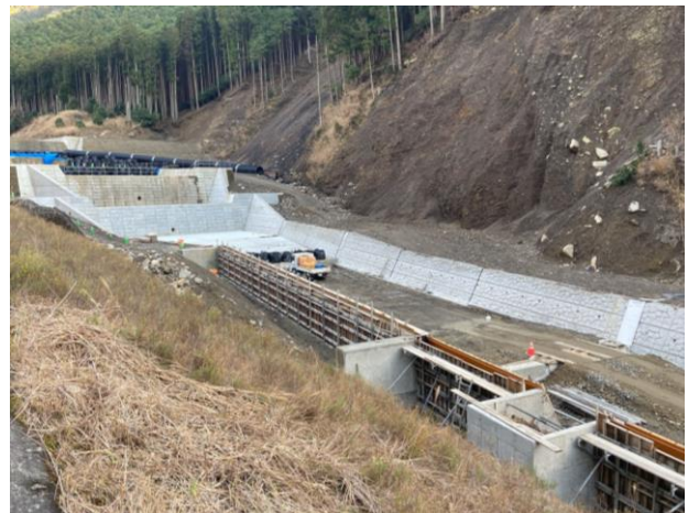
施工状況【流路】
