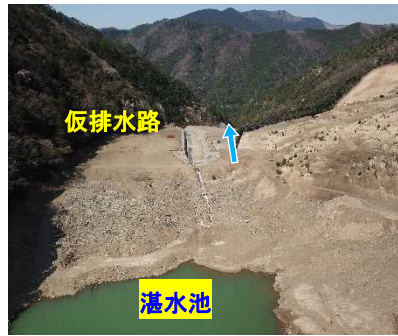
写真2. 河道閉塞 (上流より)
