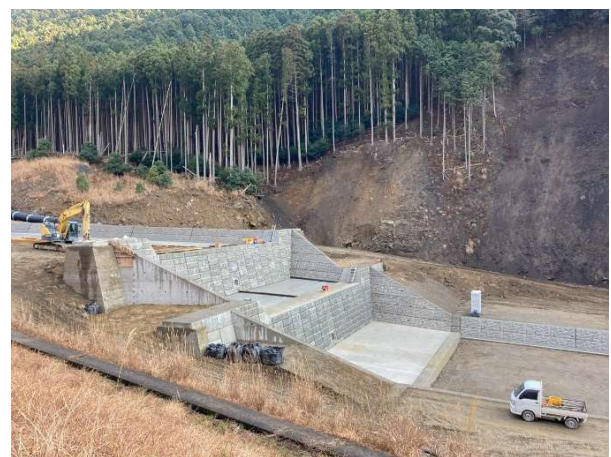
施工状況【流路】
