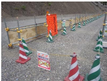
写真-6 作業通路
