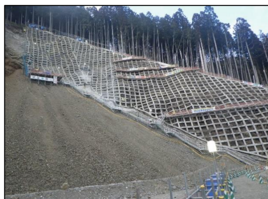
写真-1 施工状況
