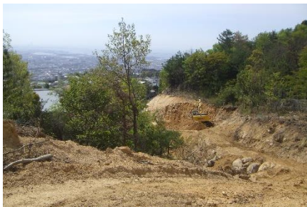
写真-6 工事用道路施工状況
