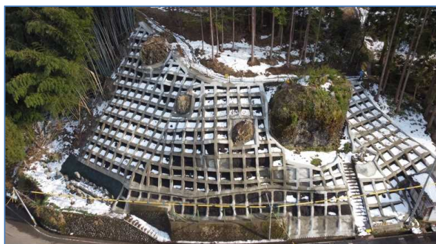
・ 完成写真① (工区全体)
