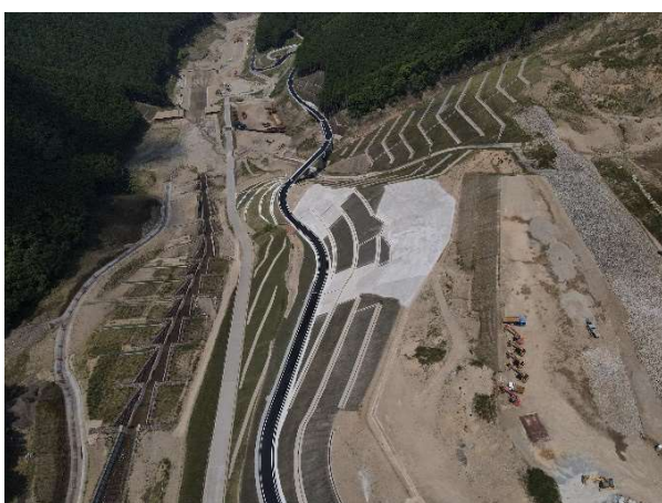
施工状況 空撮【舗装(市道復旧)】
