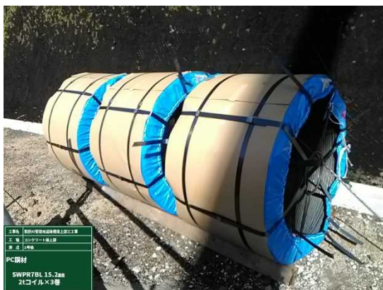
写真-5 PC鋼材の搬入設状況
