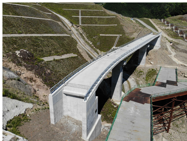
写真-10 施工完了（2号橋）
