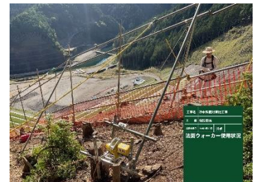
写真-20 昇降状況
