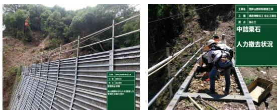
写真 3 手すり設置および作業状況
