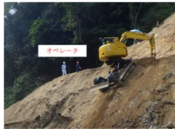
写真-11 無人化施工
