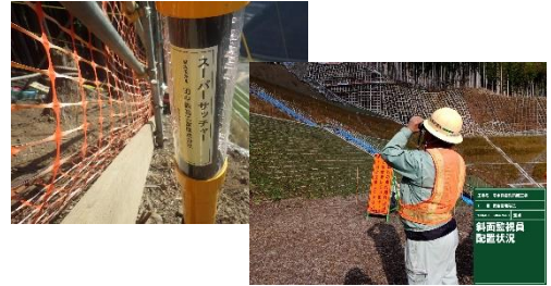
写真-3 土砂崩壊対策
