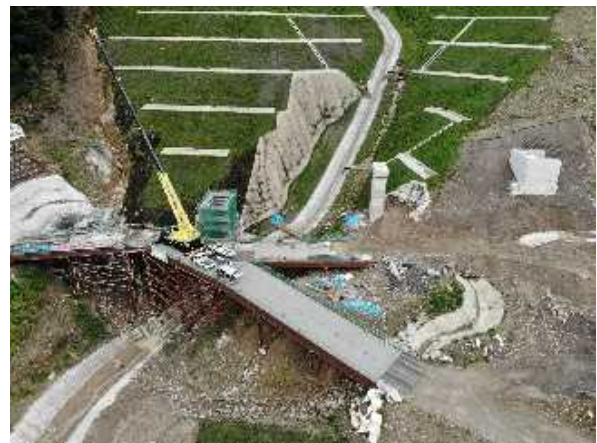
b) 2号橋架設現場
