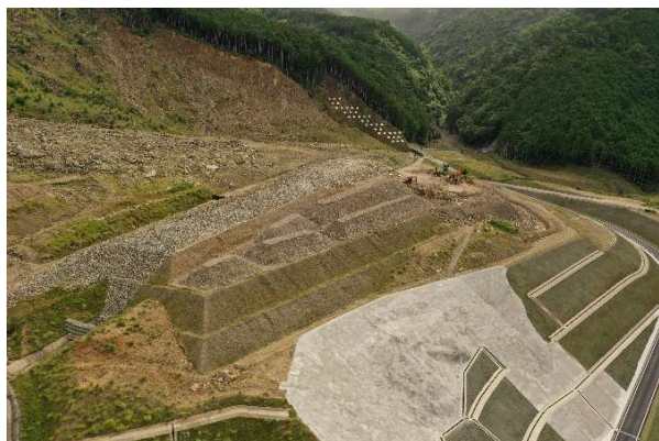
ドローンによる点検
