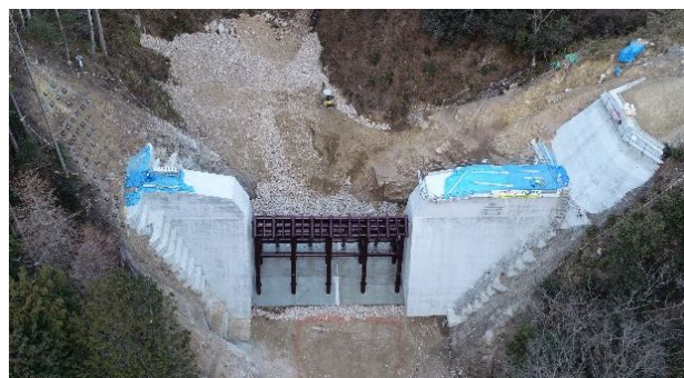
写真-1 工事現況(令和4年1月末現在)
