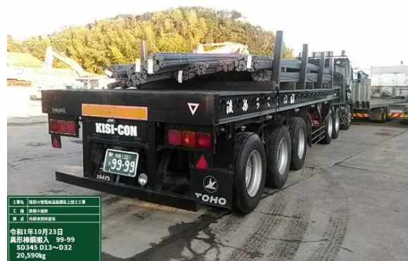
写真-3 鉄筋の運搬状況
