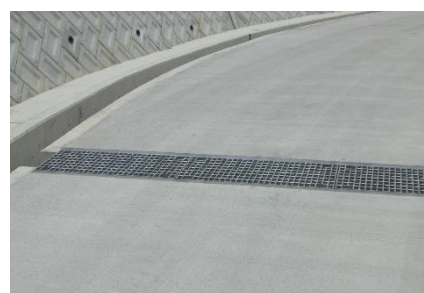
写真-9 Co舗装、水路、横断側溝完成
