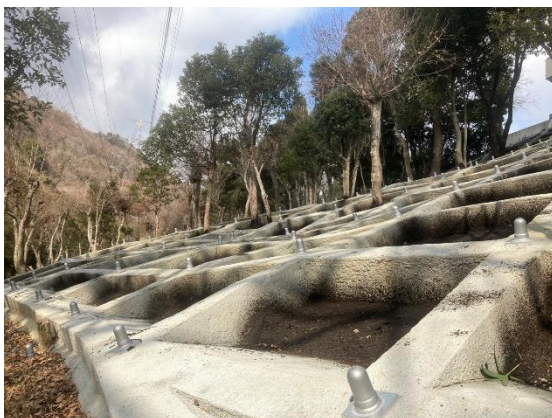
■ 写真-1 北工区：斜面西側より撮影
