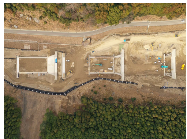
施工状況 空撮【流路】
