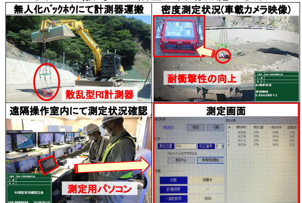
図-12 現場密度測定状況(操作室)
