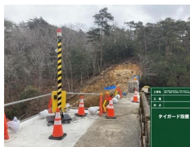
現場設置状況
