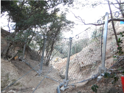
写真-2. 土石流防護柵（上流側）
