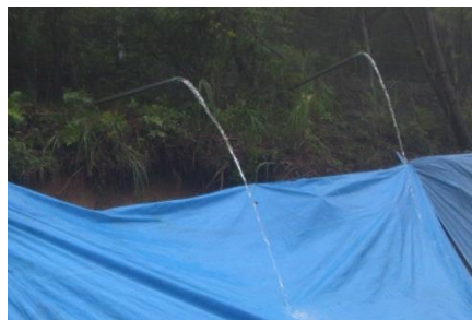
写真-13 水抜パイプ排水拡大写真
