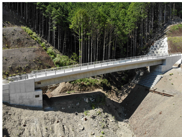
写真-9 施工完了（1号橋）
