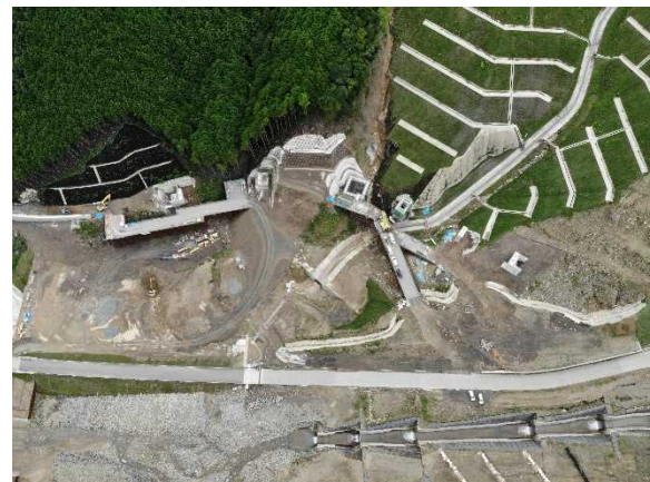
写真-1 現場全景（着手前）
