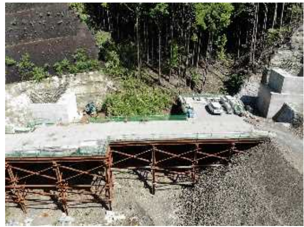
a) 1号橋架設現場
