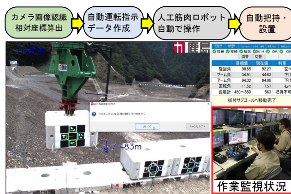
図-9 ブロック設置の自動化施工状況
