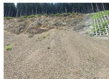
写真-2 施工前状況
