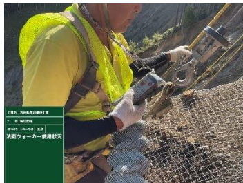
写真-19 昇降状況
