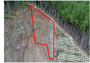
写真-12 施工箇所
