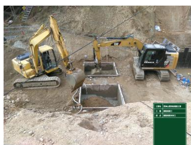
写真 4 流動タイプ施工状況
