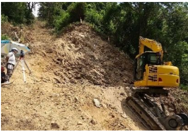
写真-10 施工状況
