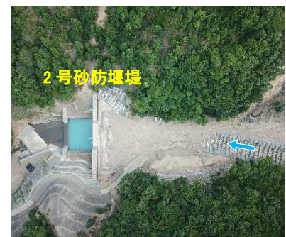
写真-3. 2号砂防堰堤
