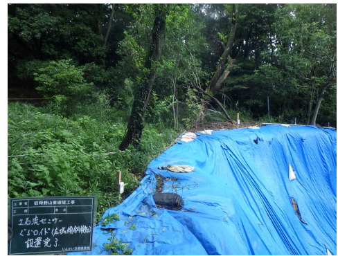
写真-4. グラロイド設置
