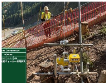
写真-18 法面ウォーカー
