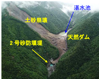
写真-1. 河道閉塞全景状況
