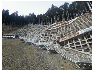
写真-7 昇降設備と材料置場
