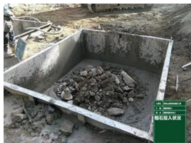
写真 7 粗石投入状況
