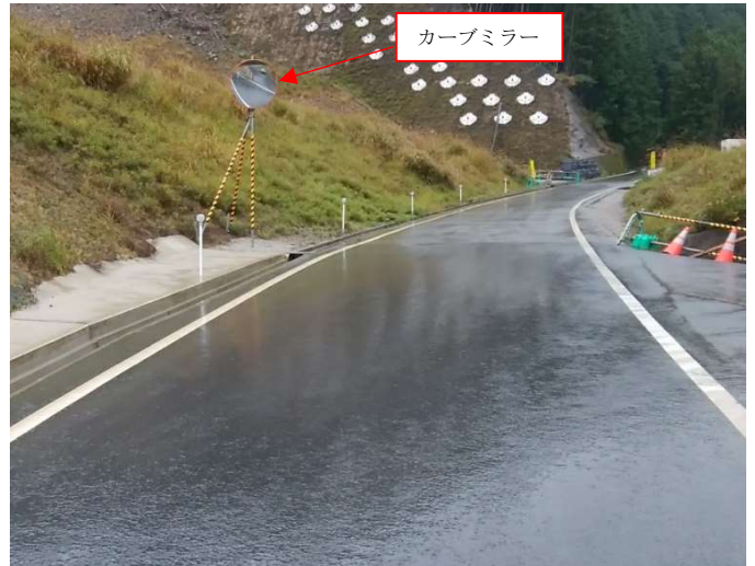
カーブミラー設置
