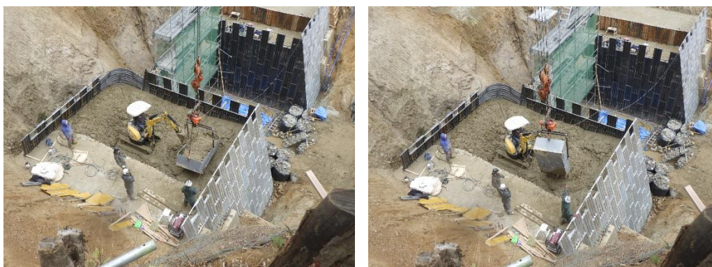
写真 10 ベッセルの打設機構改善
