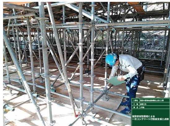
写真-7 有資格者による支保工の点検
