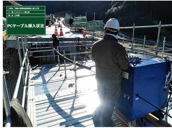
写真-6 PC鋼材の挿入設状況
