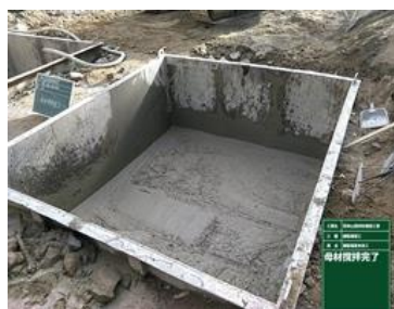
写真 6 母材混合攪拌完了
