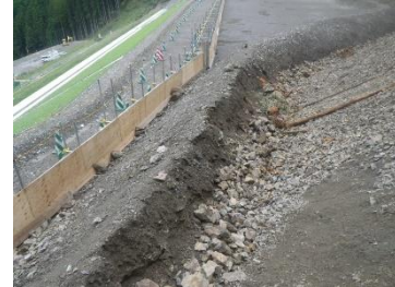
写真-4 落石対策
