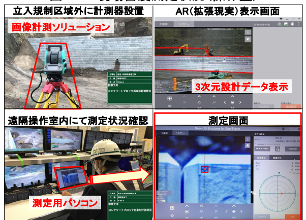
図-13 ブロック出来形測定状況(操作室)
