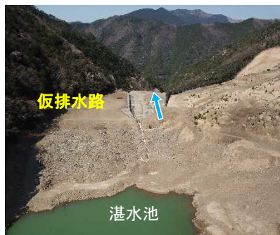
写真-2. 仮排水路
