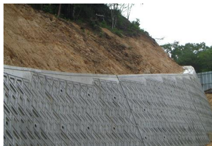
写真-7 工事用道路ブロック積完成
