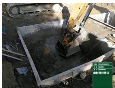
写真 5 母材混合攪拌
