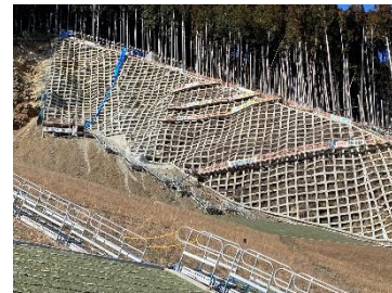
写真-5 各種仮設備
