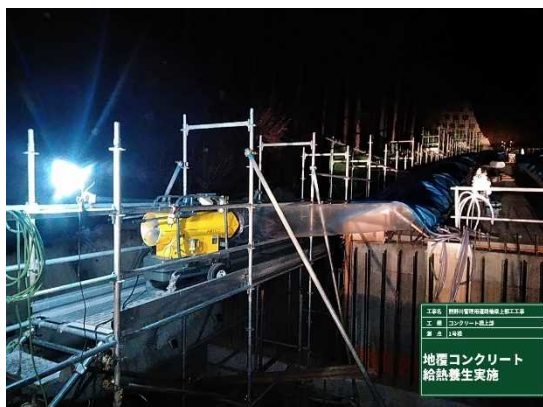
写真-8 夜間のジェットファーンネス可動
