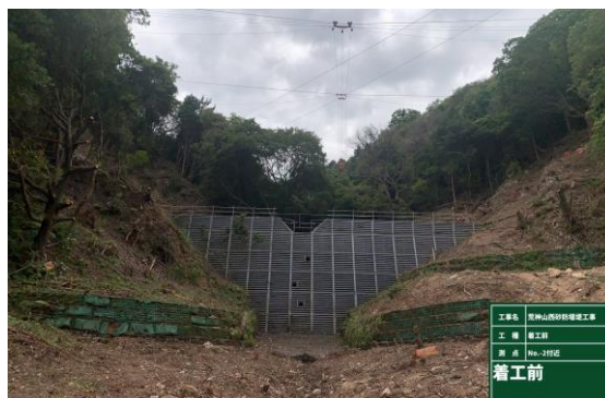
写真 1 既設鋼製枠堰堤
