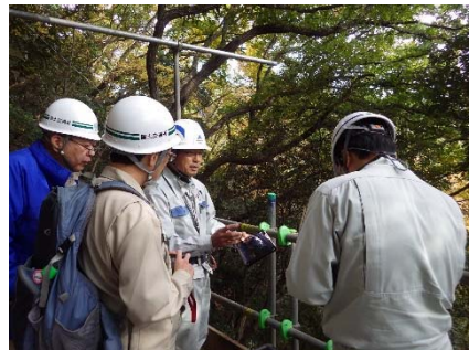
■ 写真-11 出来形検査状況
