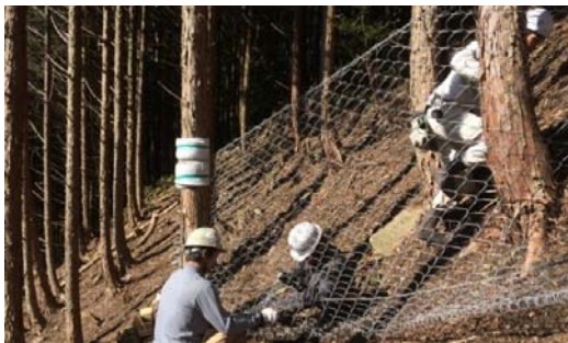
写真-8 施工上部落石防止ネット
