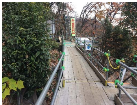
■ 写真-3 作業通路の整備状況
