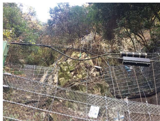
写真-2 清水地区の施工状況
