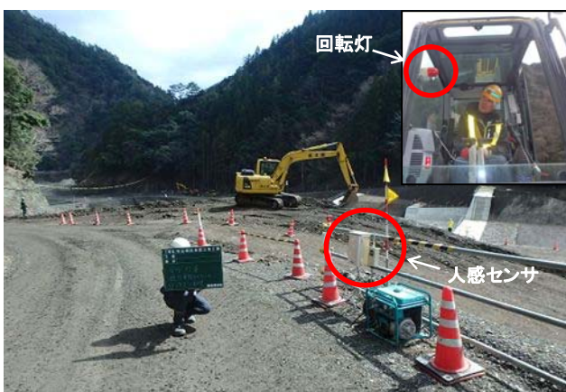
写真-5 重機土工作業状況 (その 1)
