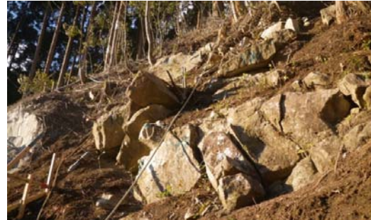
写真-7 現況生活道路上部法面状況
