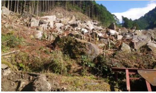
写真-6 伐採後現地状況
