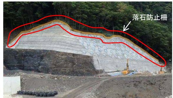
写真-9 左岸法面全景 (落石防止柵設置完了後)
