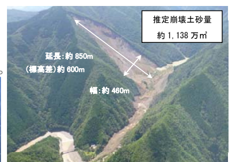
写真-2 崩壊斜面状況
