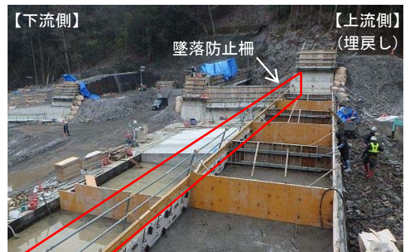
写真-10 墜落防止柵設置状況
