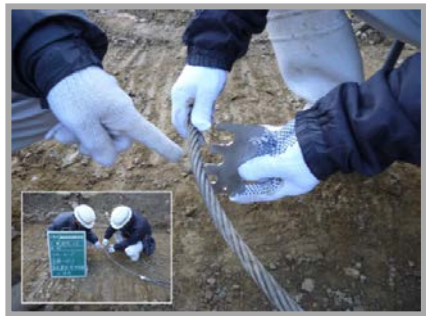
簡易測定器を用いた摩耗率点検状況
