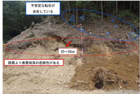
写真-8 左岸法面近景
