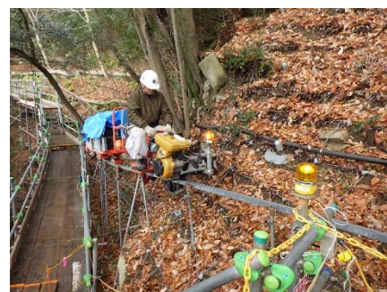
■ 写真-8 モノレールの稼働状況を見える化
