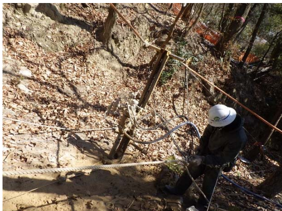
写真-1 鶴甲地区の施工状況
