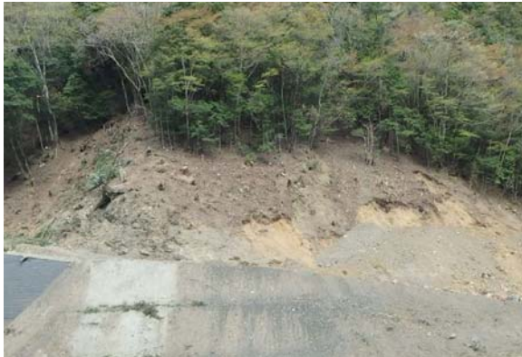
写真-7 左岸法面全景 (伐採作業完了後)
