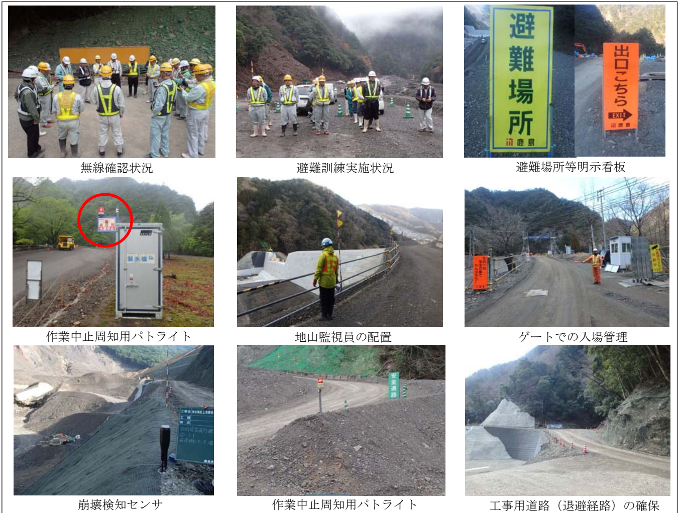
写真-4 土砂崩壊による二次災害防止対策への取組み事例
