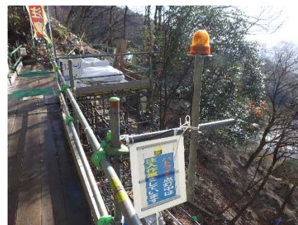
■ 写真-7 注入ポンプの稼働状況を見える化
