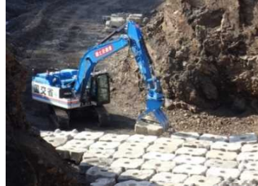
図-13 根固めブロック据付工
