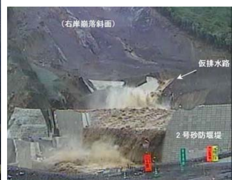
写真-3 越流状況(平成26年台風11号)
