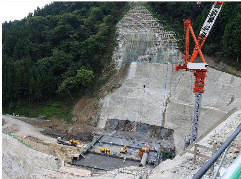
吉野瀬川ダムの工事状況
