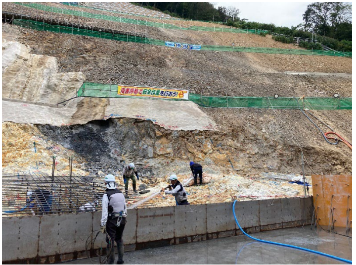
吉野瀬川ダムの地質（堤体左岸）
