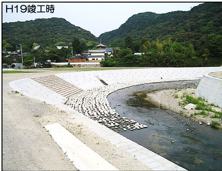
石積護岸と石付護床工
