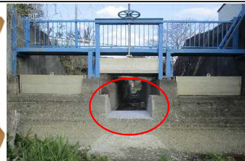
▶熊取大池の余水吐切下げ
