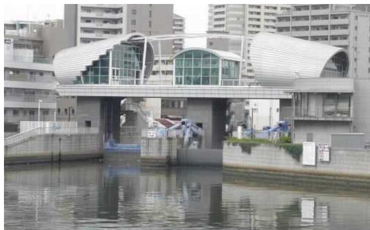
写真-1 道頓堀川水門
