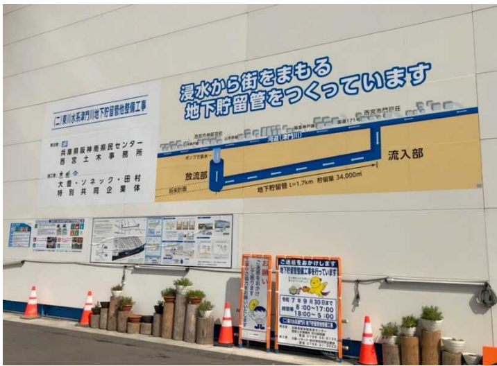
津門川貯留管整備事業
