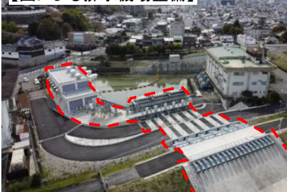
【国による排水機場整備】
