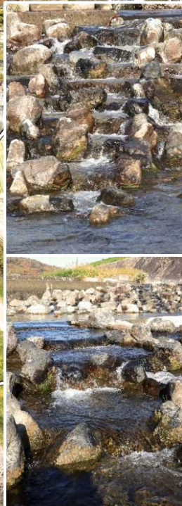
川島井堰の魚みち 石で魚道を作った、全国でも非常に珍しい取り組み事例。
