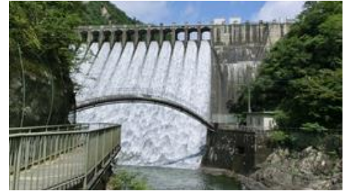
図-3 千叅ダム本堤
