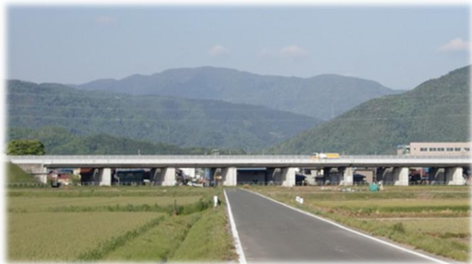
図-3 避溢橋の設置例(長浜市)
