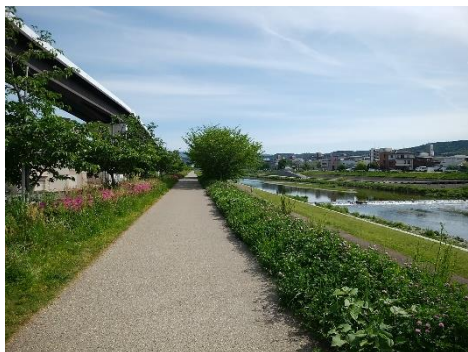
鴨川改修工事 遊歩道整備
