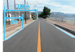
100m毎に5mのブルーライン(破線)を設置
