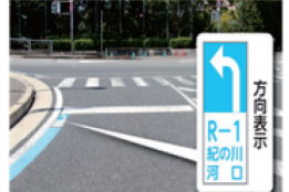
交差点直前にのみ、進行方向等を示す路面標示と5mのブルーラインを設置
