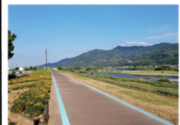
道路の両端にブルーライン(実線)を設置
