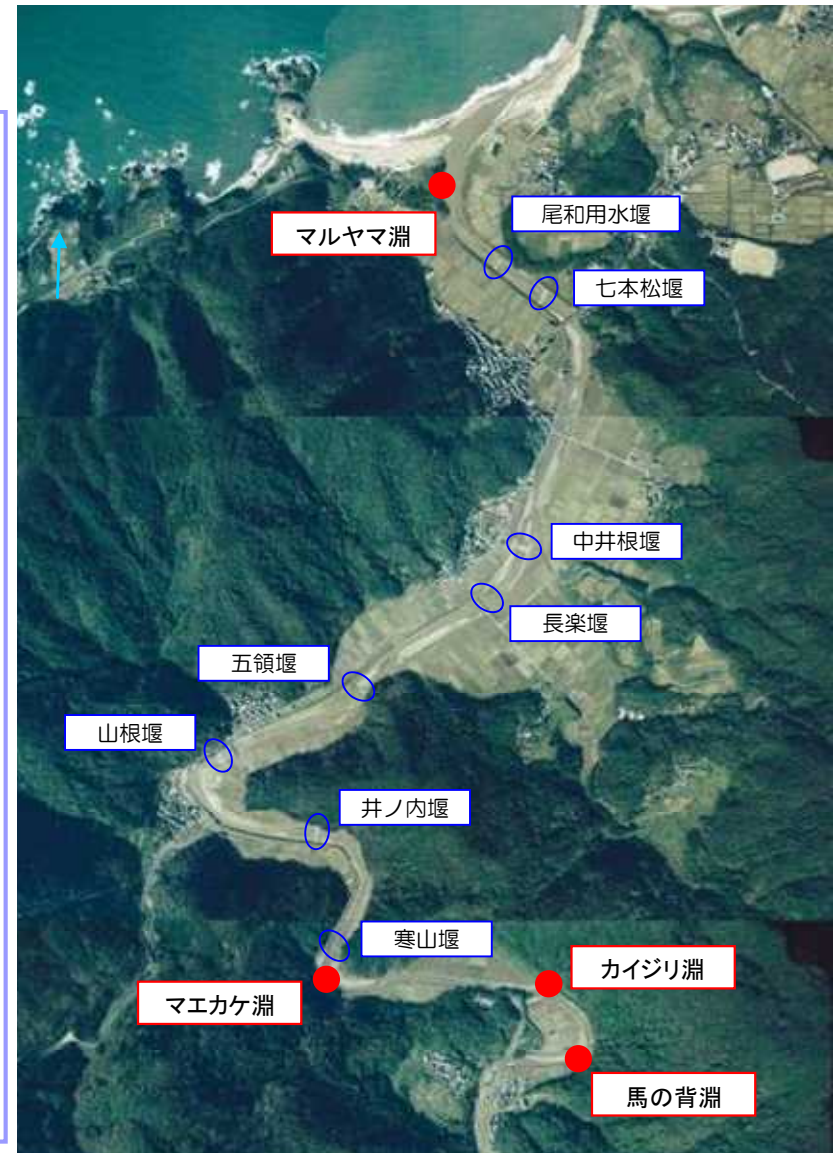
宇川に数多く設置されている堰
