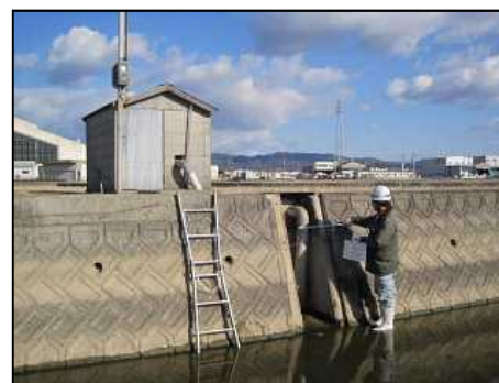
ポンプ取水箇所
