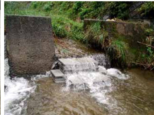
O井堰(階段構造)設置状況
