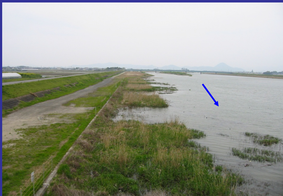
河川縦断方向(撮影箇所:中州大橋)
