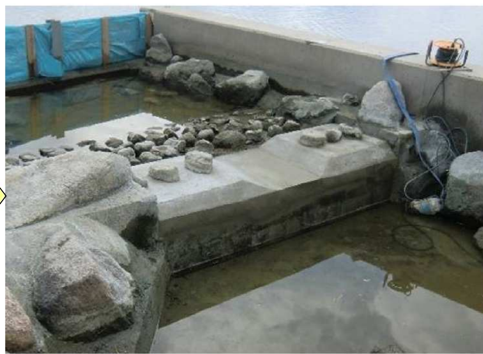
写真 完成(通水前)
