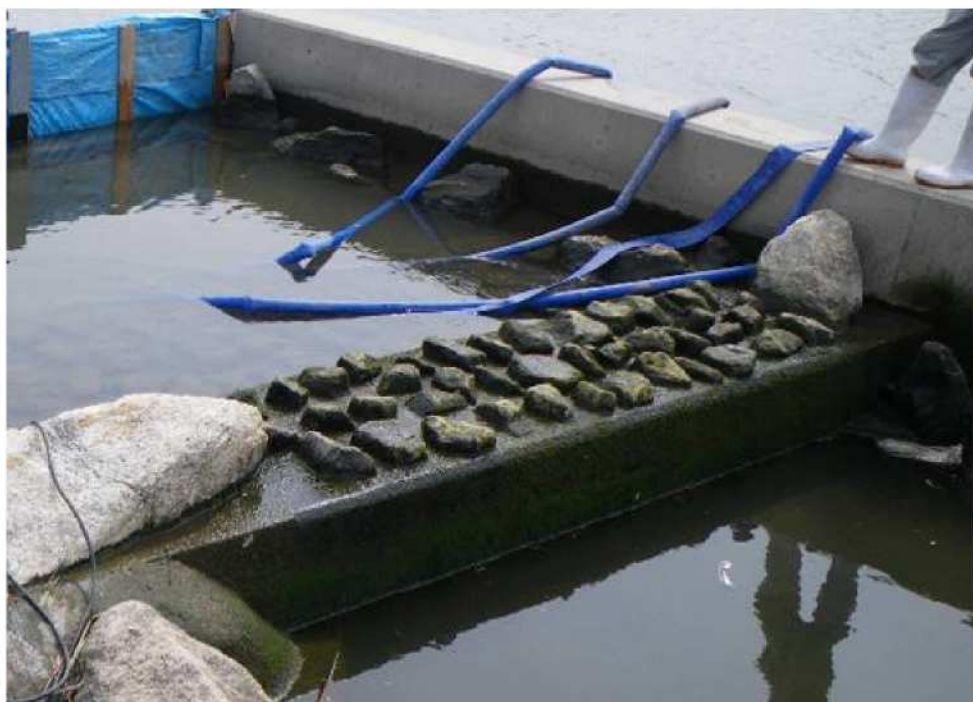
写真 着手前(新設魚道改良工事前)
