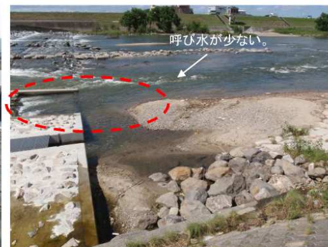
写真 魚道入口
