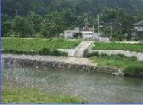
親水階段(高水護岸部)
