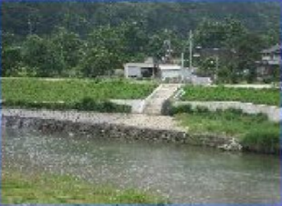
親水階段 (高水護岸部)
