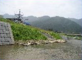
親水護岸(低水護岸部)
