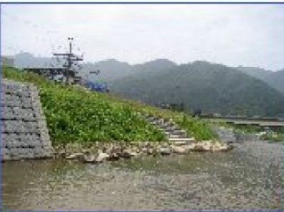
親水護岸 (低水護岸部)
