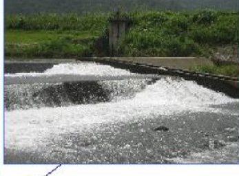
井堰の落差を解消したスロープ
