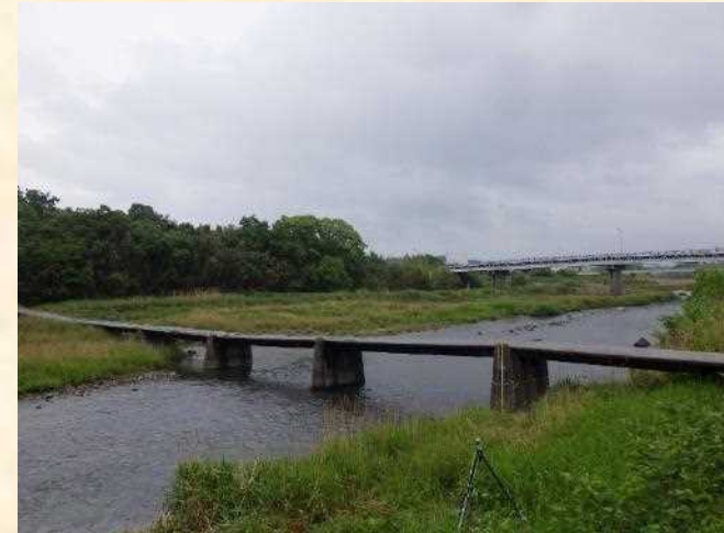
10:00 水位上昇量0.00m
