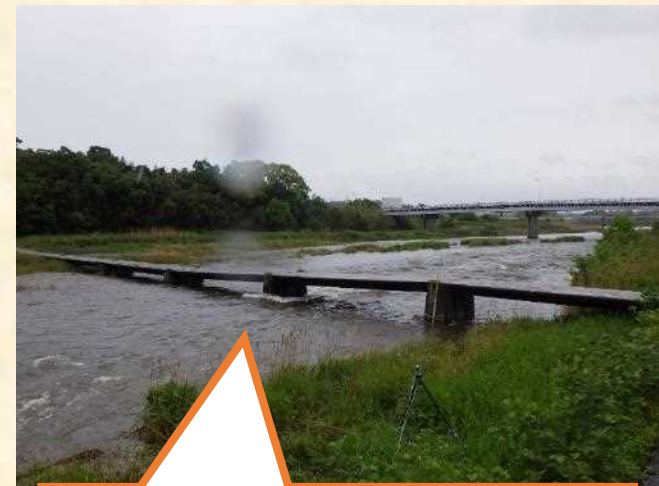
放流量合計90m 3 /sでは通行止にならない
