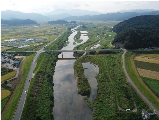
湿地再生(加陽地区)の完成写真(R4.9撮影)
