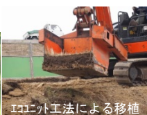
エコネット工法による移植
