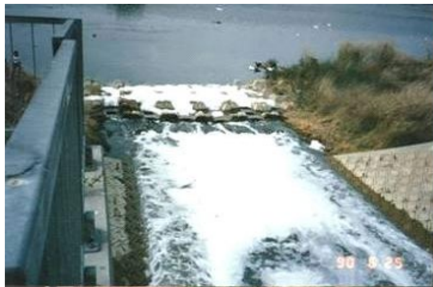
流入支川から汚濁水の流入
