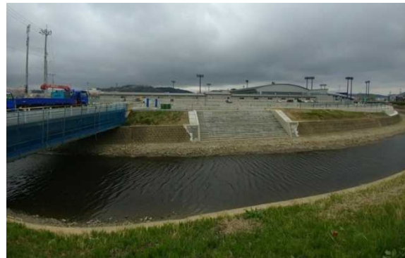
階段護岸の施工
