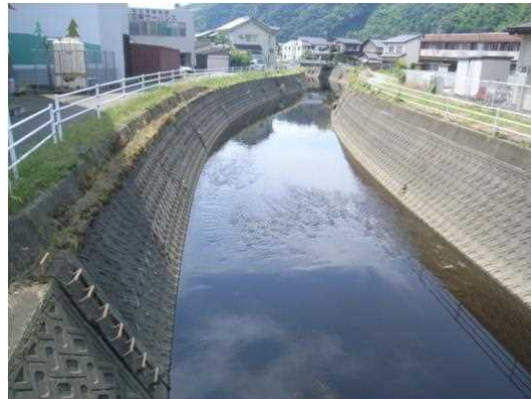
単調な河川断面(低水路工事前)
