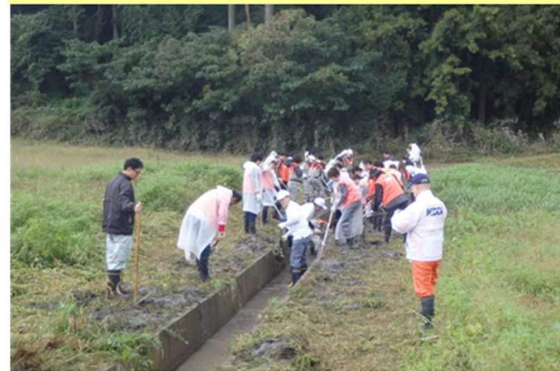
導水路を掃除して頂きました
