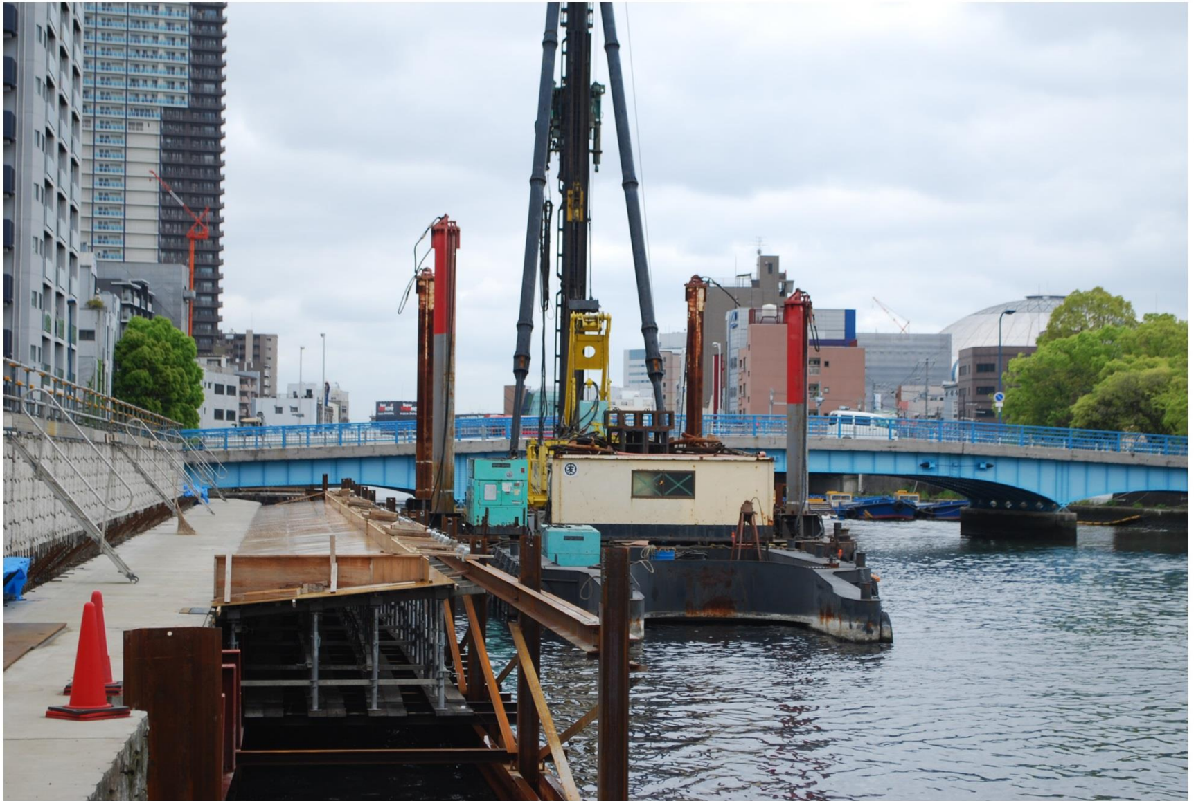
護岸から張り出すスラブで遊歩道部分を拡幅
