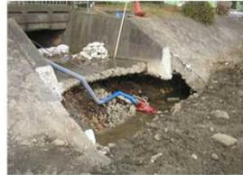
写真3.6-1 護岸空洞化の状況写真 (平成19年1月に瀬田川で発見)
