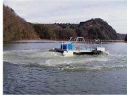
写真 4.2.5-3 循環曝気設備稼働状況
