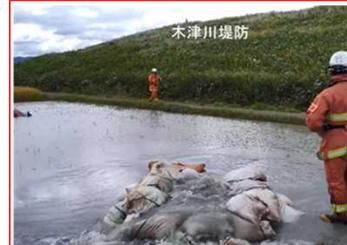
写真 3.3.1-14 木津川における堤防漏水の状況 (平成29年台風21号)
