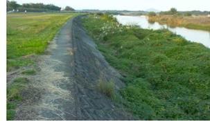
写真 3.2.7-1 コンクリート護岸
